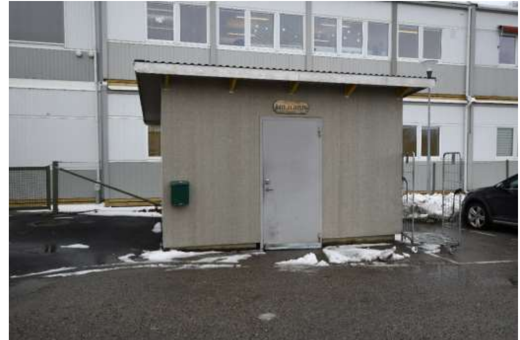
Brandskyddsinklädnad av avfallshuset
