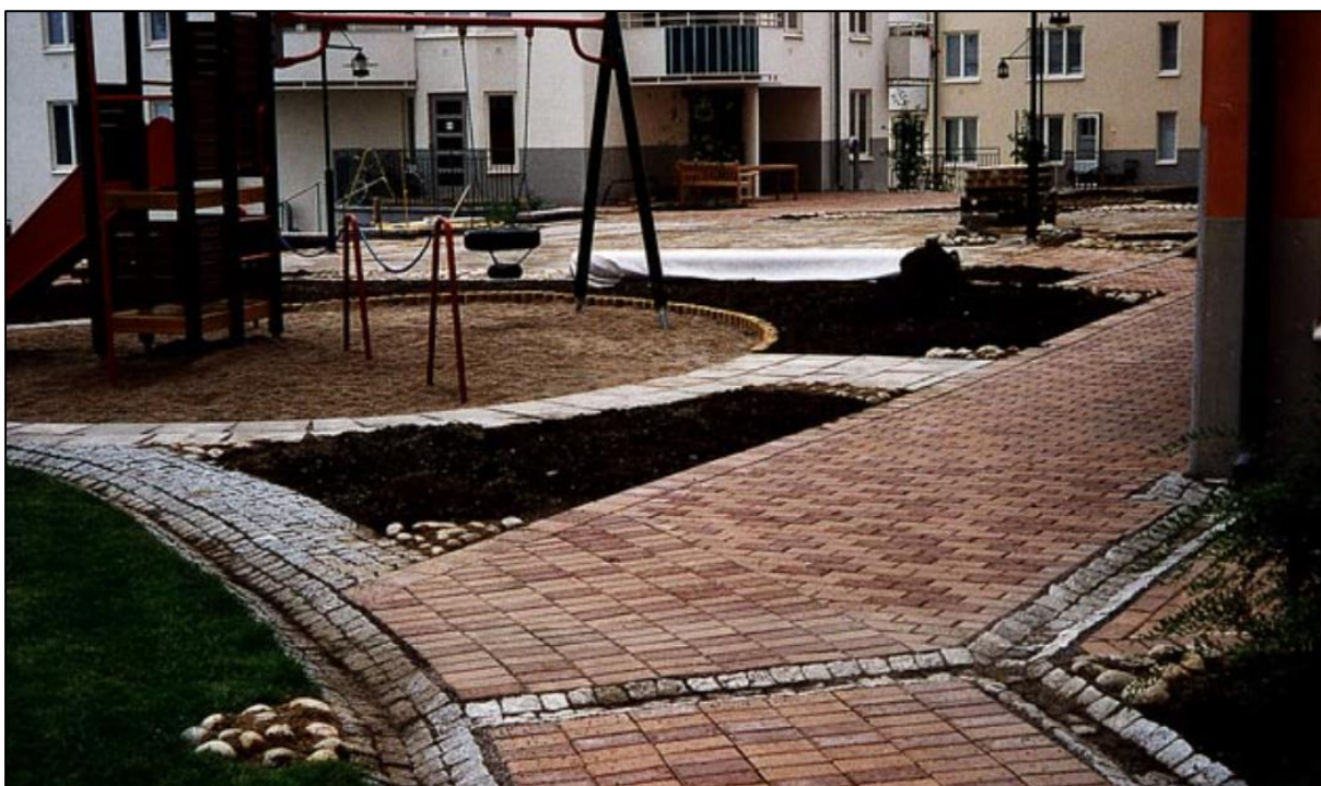
Figur 5-2. Exempel på avledning av takvatten via ränndalar anlagda med gatsten (Källa: Stockholm Vatten AB, n.d.).
