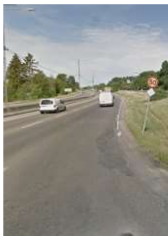
Bild 2. Före: Ulvsundavägen med spår av tidigare lagningar.
