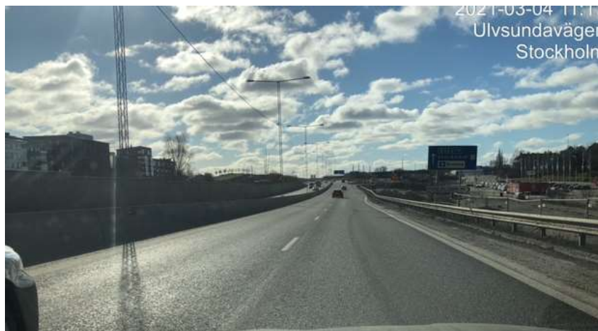
Bild 3. Efter: Ulvsundavägen med nytt slitlager asfalt.
