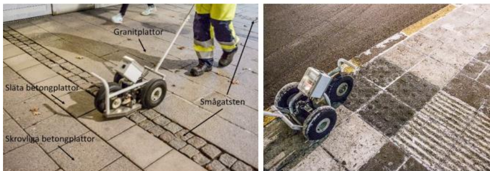
Bild 1. Den stora variationen av material är en utmaning för driftsfordonen.
