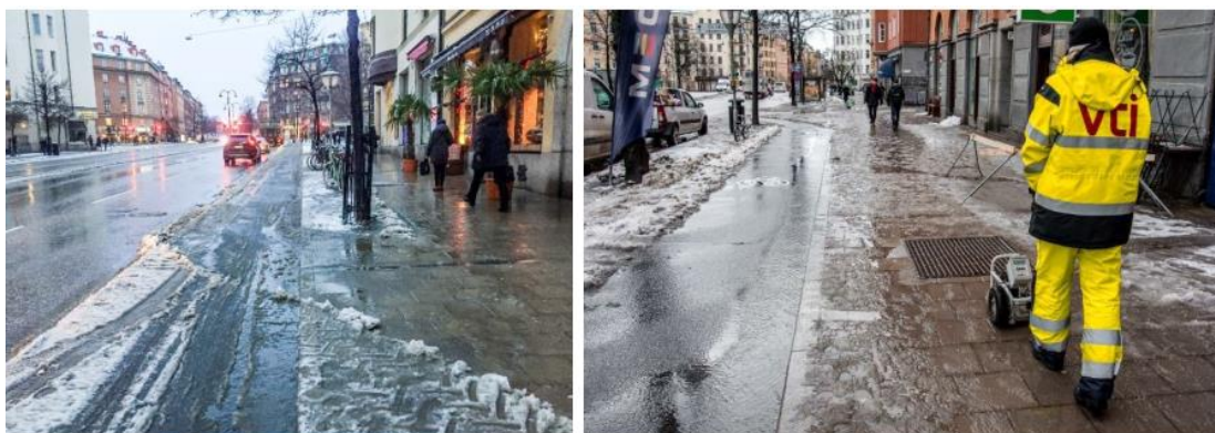
Bild 18. Möblering och hinder gör det svårt att komma fram med driftsfordon.
