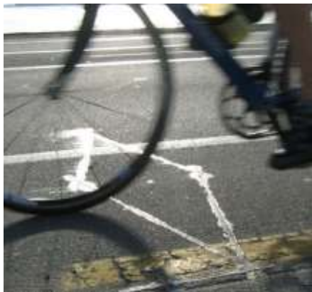
Figur 4: Cyklar räknas automatiskt av slingor som ligger nedfrästa i asfalten.
