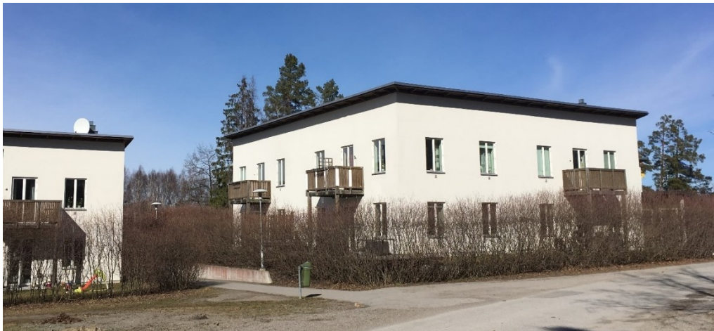
Två av de s.k. BoKlok-husen
