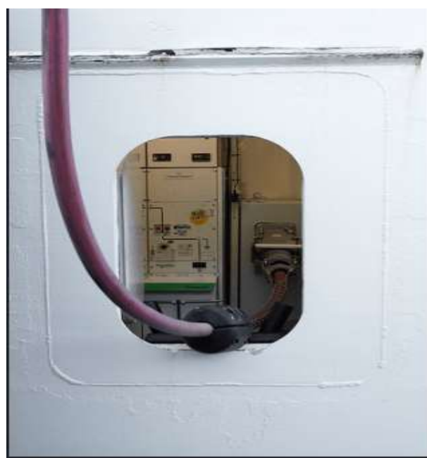
Bild 6. Bilder landelanslutning på Värtapiren. Landelanslutning ger en stor positiv effekt på hamnens miljöpåverkan eftersom man då eliminerar avgaser och buller från fartyg som går på tomgång under tiden de ligger vid kajen. Projektet med att förse samtlig kajplatser i Värtahamnen med landelsanslutning slutfördes under 2019. Nu är Stadsgården på tur. Bildkälla: www.stockholmshamnar.se
