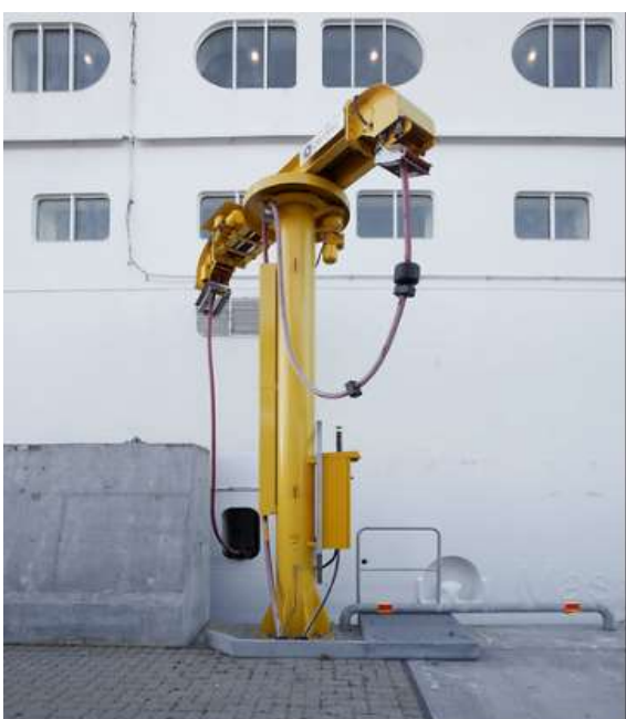
Bild 6. Bilder landelanslutning på Värtapiren. Landelanslutning ger en stor positiv effekt på hamnens miljöpåverkan eftersom man då eliminerar avgaser och buller från fartyg som går på tomgång under tiden de ligger vid kajen. Projektet med att förse samtlig kajplatser i Värtahamnen med landelsanslutning slutfördes under 2019. Nu är Stadsgården på tur. Bildkälla: www.stockholmshamnar.se
