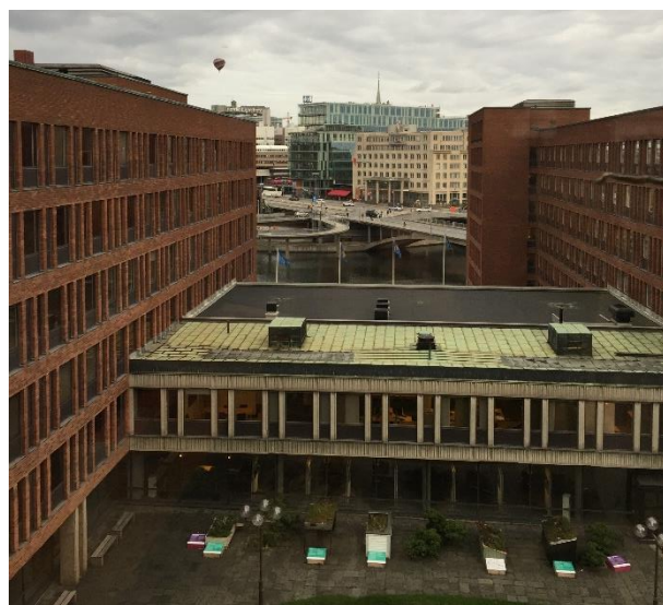
Bild 2. Tekniska nämndhusets med ett av fastighetens befintliga koppartak i bild. Foto: Jenny Pirard.
