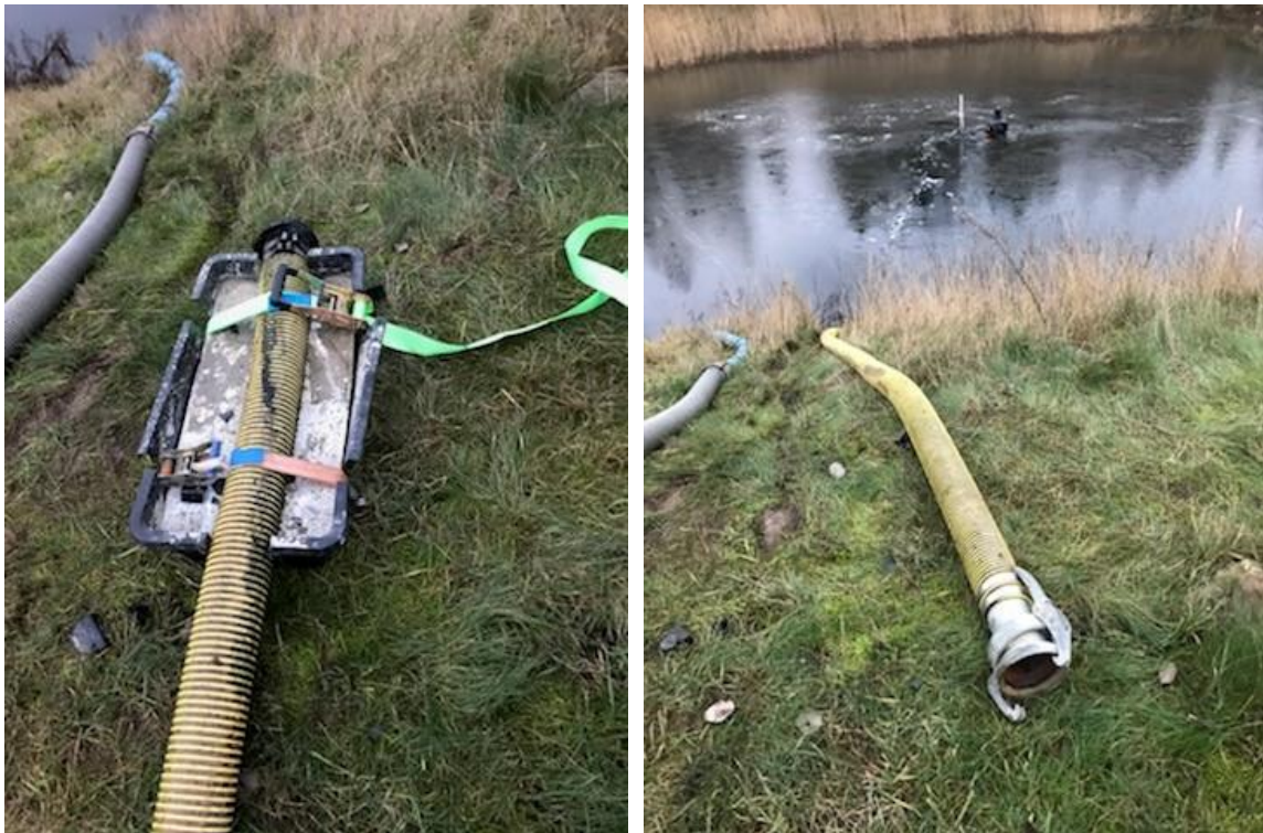
Figur 7 Arbeten med att sänka ned tömningsslangen.
