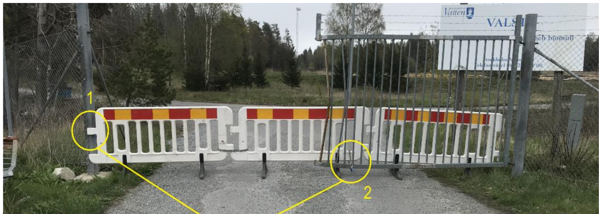
Figur 4 Provisorisk grind i väntan på den nya skjutgrinden, 1 och 2 indikerar var kombinationslåsen sitter.
