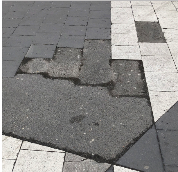
Figur 6. Trasig beläggning har ersatts med asfalt.
