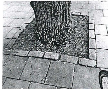
Stenmjölsyta i anslutning till Björns Trädgård. Höjsättnings- och avvattningsproblem.
