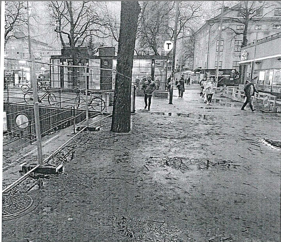
Stenmjölsyta i anslutning till Björns Trädgård. Höjsättnings- och avvattningsproblem.
