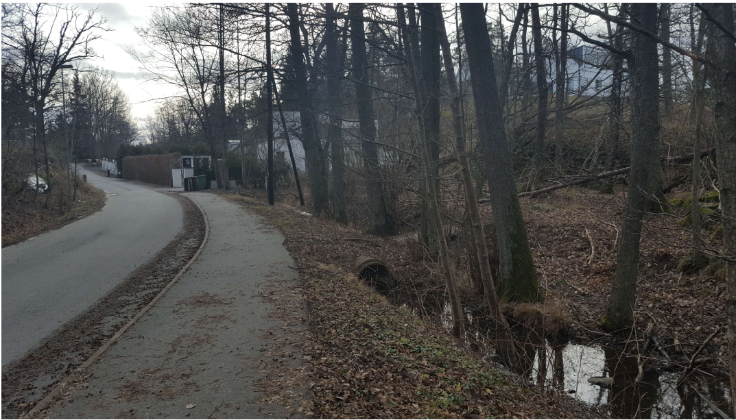
Figur 12. Det öppna dikets leds sista biten till Öringesjön via ledning och mynnar ut vid Slumnäsvägen. Bild källa: WRS, 2020-02-25.
