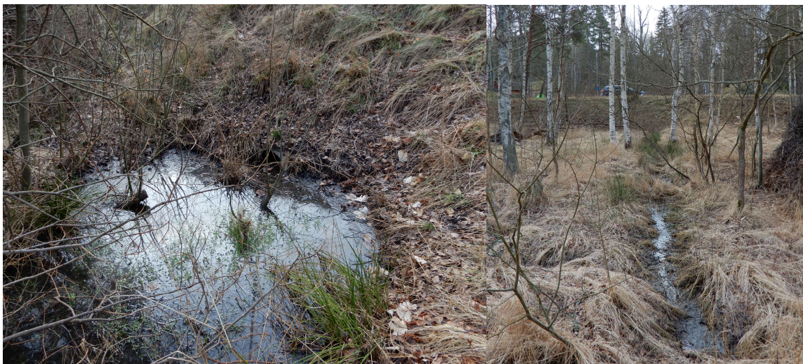
Figur 8. Bild till vänster visar utlopp strax efter vägslänten till Tyresövägen där dagvattnet mynnar ut i ett betongrör och ses i vattenspegelns övre del. Vid dagvattenledningens mynning föreslås djuphålan att anläggas. Bild till höger är taget från GC-väg mot Tyresövägen och visar det smal öppna diket som börjar vid vägslänt och sedan leds under GC-väg. Bild källa: WRS, 2020-02-25.
