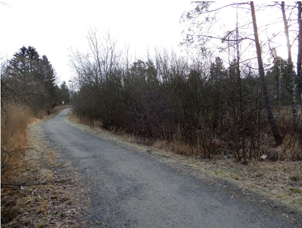
Figur 9. GC-väg skapar idag en naturlig barriär för dagvattnet och föreslås bevaras. Till höger om GC-vägen i bilden ses den yta dit dagvattnet först ansamlas efter dagvattenledning därefter leds vattnet under GC-väg vidare ut i befintlig våtmark. Bild källa: WRS 2020-02-25.
