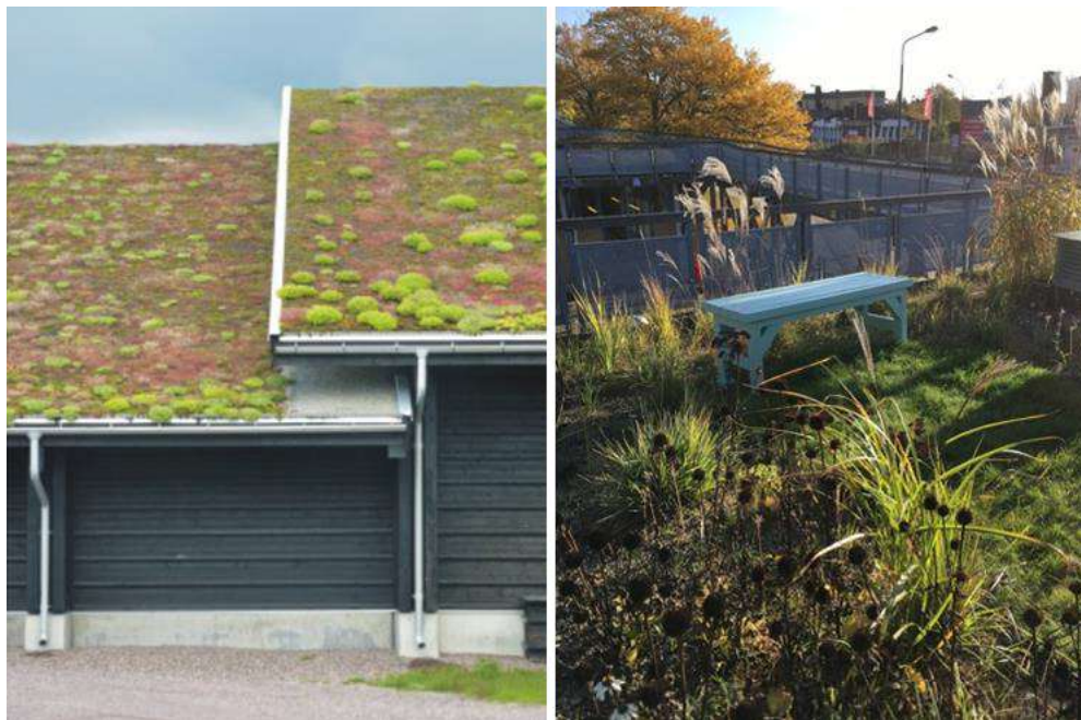
Figur 7. Exempel på tunna (till vänster) och tjocka (till höger) gröna tak. Bildkälla WRS
