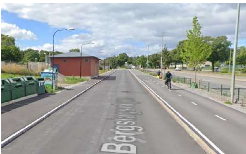
Bild 18. Efter åtgärder Bergslagsvägen
