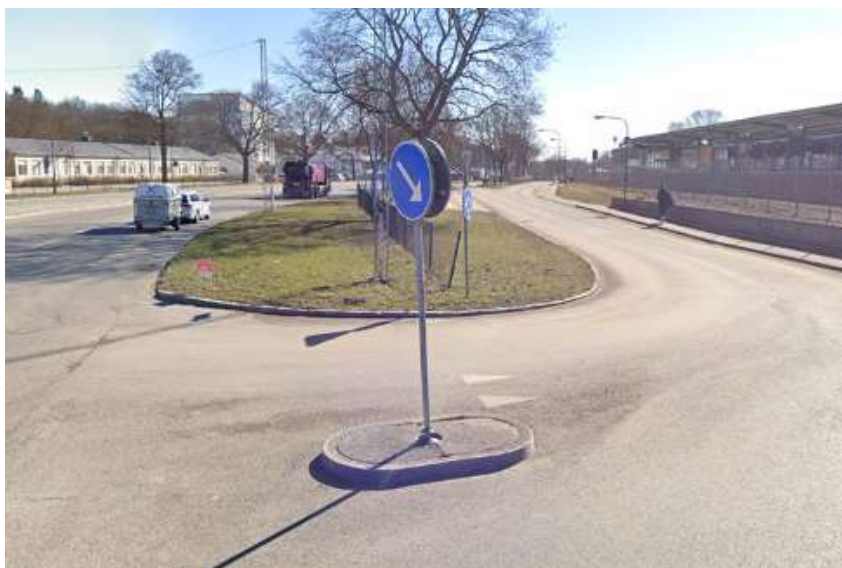
Bild 11. Före åtgärder Åkeshovs rondellen
