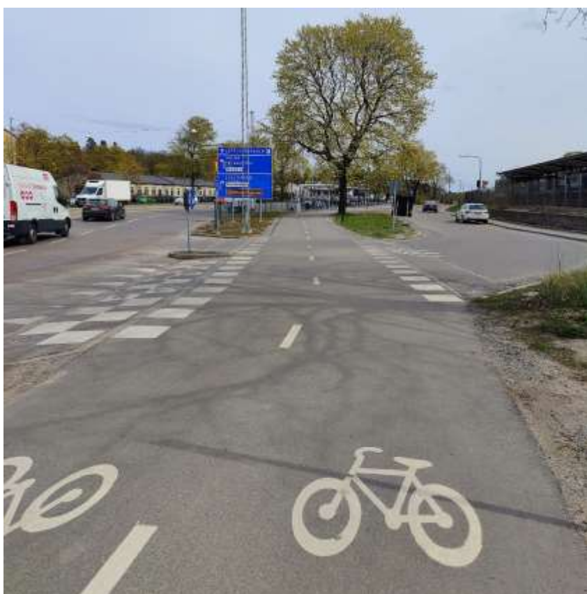
Bild 16. Efter åtgärder Åkeshovsrondellen
