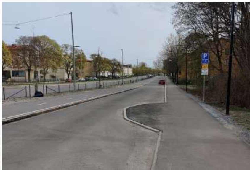
Bild 19. Efter åtgärder Bergslagsvägen
