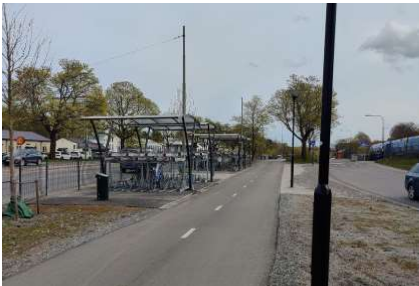
Bild 17. Efter åtgärder cykelparkeringen Åkeshov
