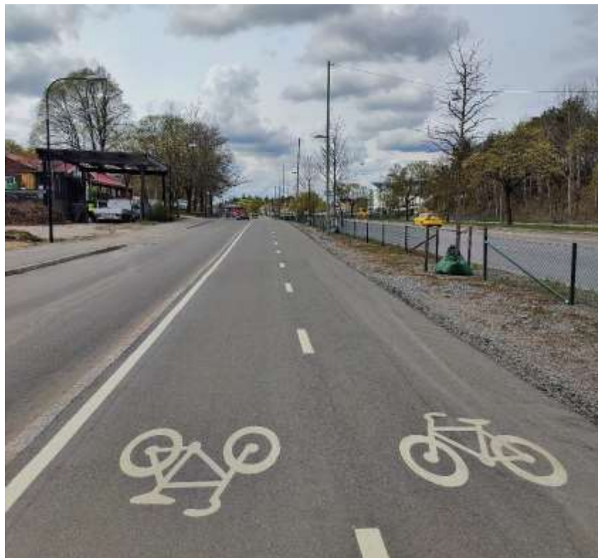
Bild 21. Efter åtgärder Bergslagsvägen.
