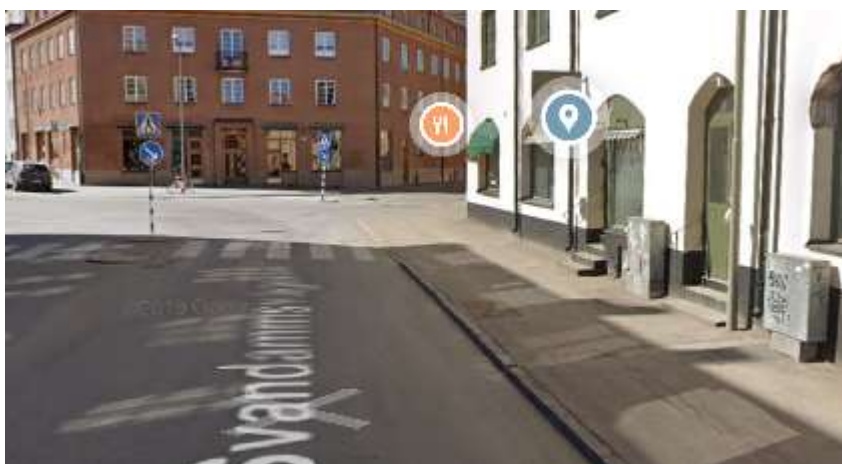
Figur 13. Bild före åtgärder, Svandammsvägen.
