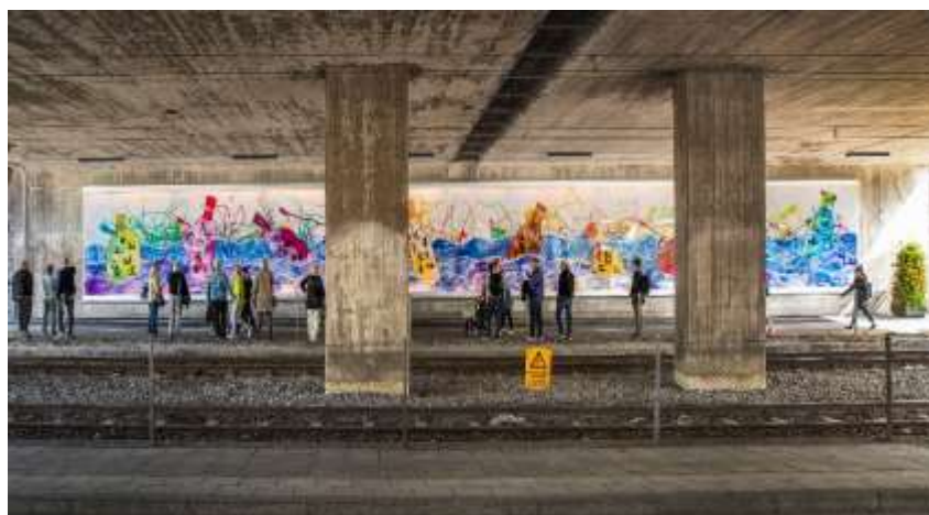
Figur 4. Bild efter utförda åtgärder, gångtunnel mellan Marievik och Liljeholmen.
