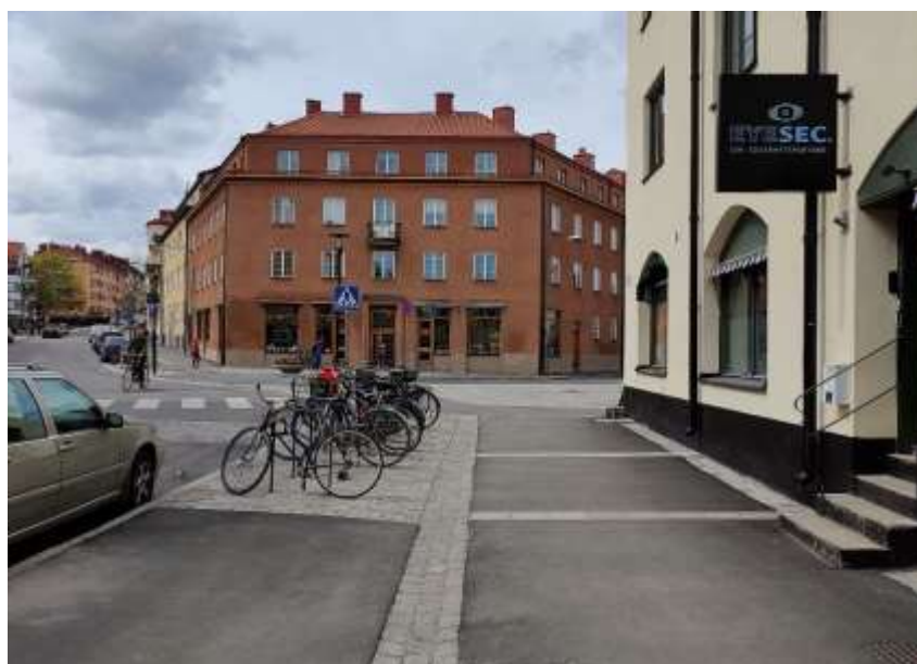
Figur 19. Bild efter åtgärder, Svandammsvägen.
