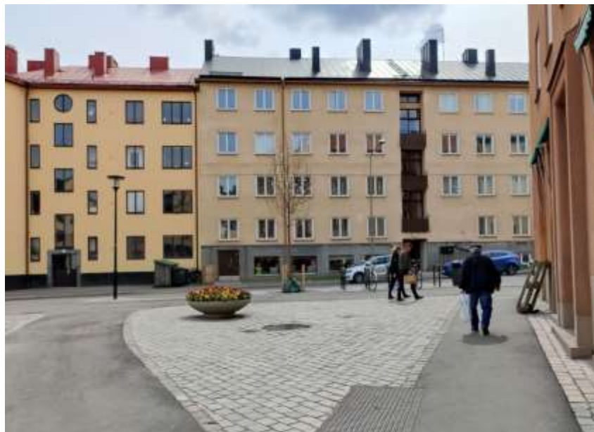
Figur 18. Bild efter åtgärder, Tegelbruksgatan.
