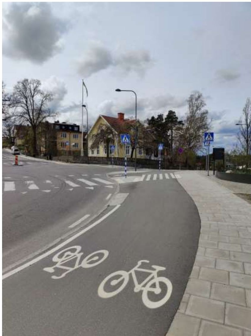
Figur 14. Badstrandsvägen efter åtgärder
