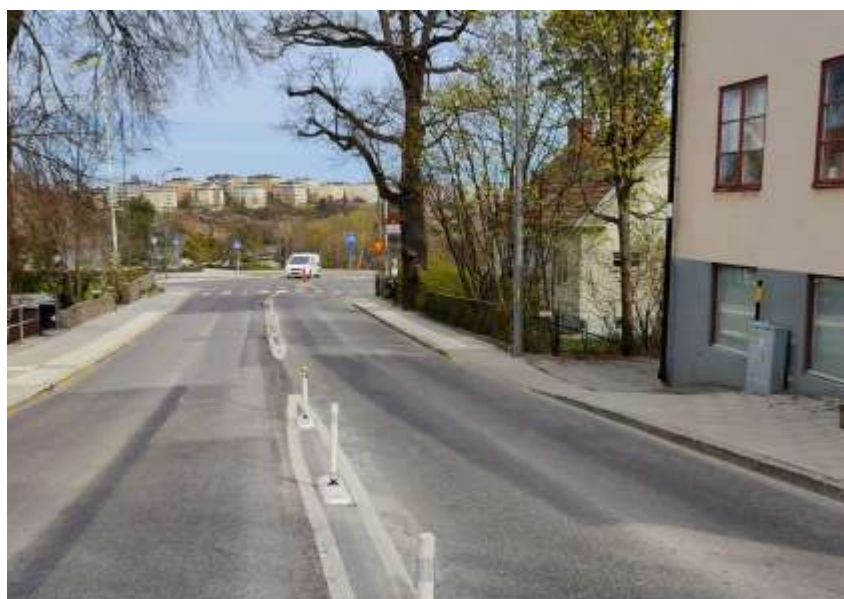
Figur 13. Badstrandsvägen efter åtgärder
