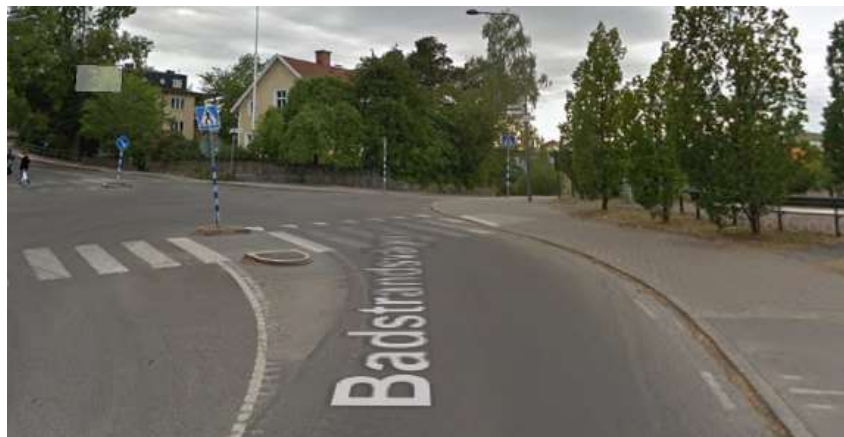
Figur 6. Badstrandsvägen före åtgärder
