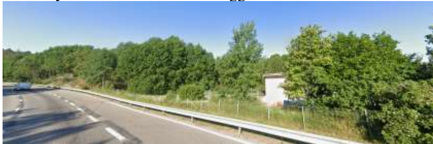
Figur 4 Vy över befintlig situation. Huddingevägen strax söder om Grossistvägen. (Google maps, juni 2020)
