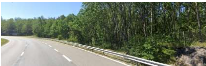
Figur 5 Vy över befintlig situation. Huddingevägen, södergående, mellan Grossistvägen och Glanshammarsgatan. (Google maps, juni 2020)
