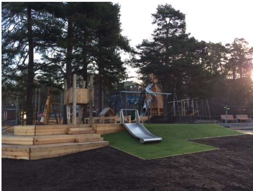
Bild efter upprustning av lekparken.
