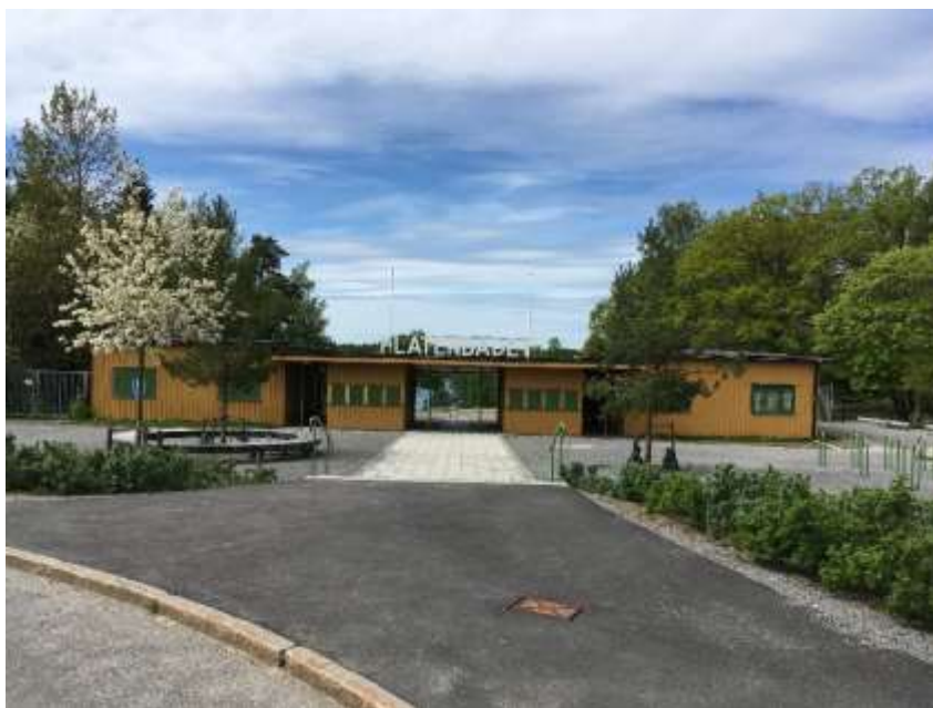
Flatenbadets huvudentré efter ombyggnation
