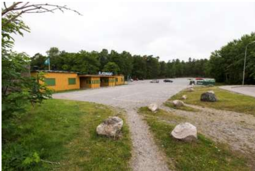
Flatenbadets huvudentré och parkering före ombyggnation
