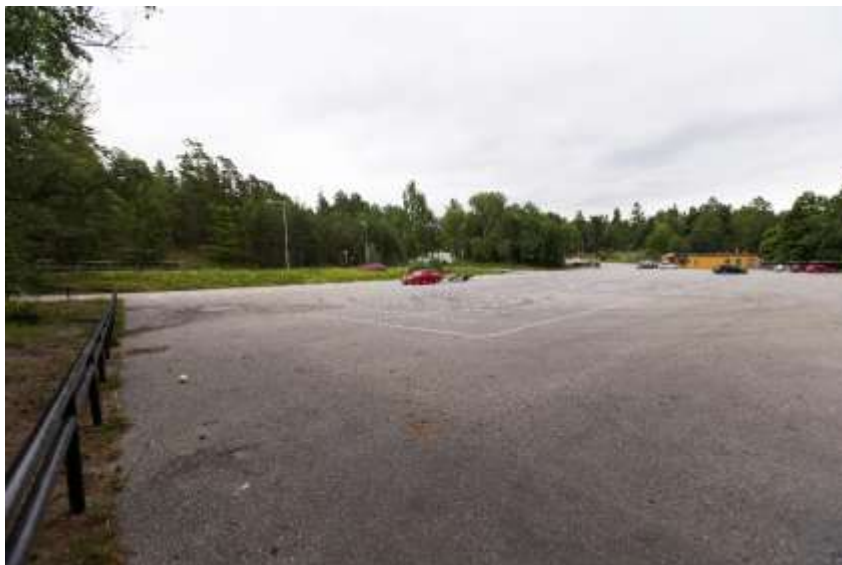
Stora parkeringen före ombyggnation
