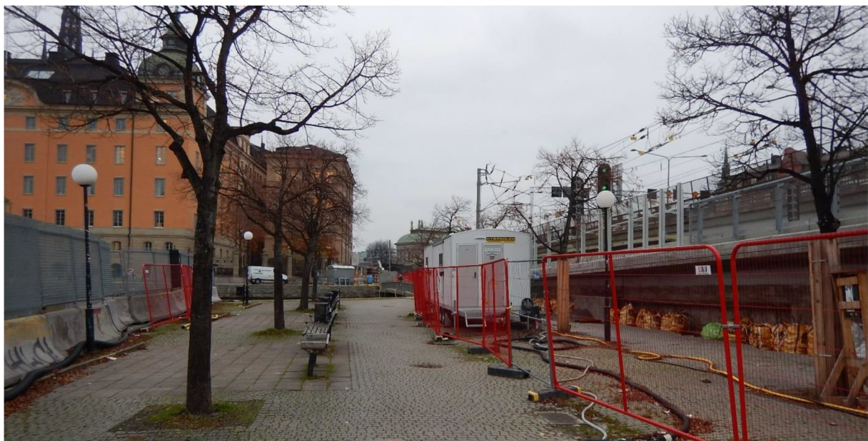
Figur 8: Befintlig gångbro (Hebbes bro) – träd, belysning, bänkar mm
