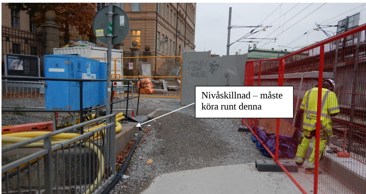
Figur 6: Befintlig gångbro (Hebbes bro) - nivåskillnad
