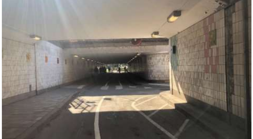
Figur 5 Gångbana och cykelbana i östra delen av tunneln.
