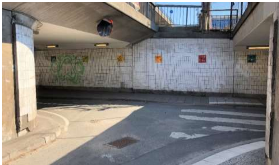
Figur 6 Den västra rampens anslutning till tunneln.
