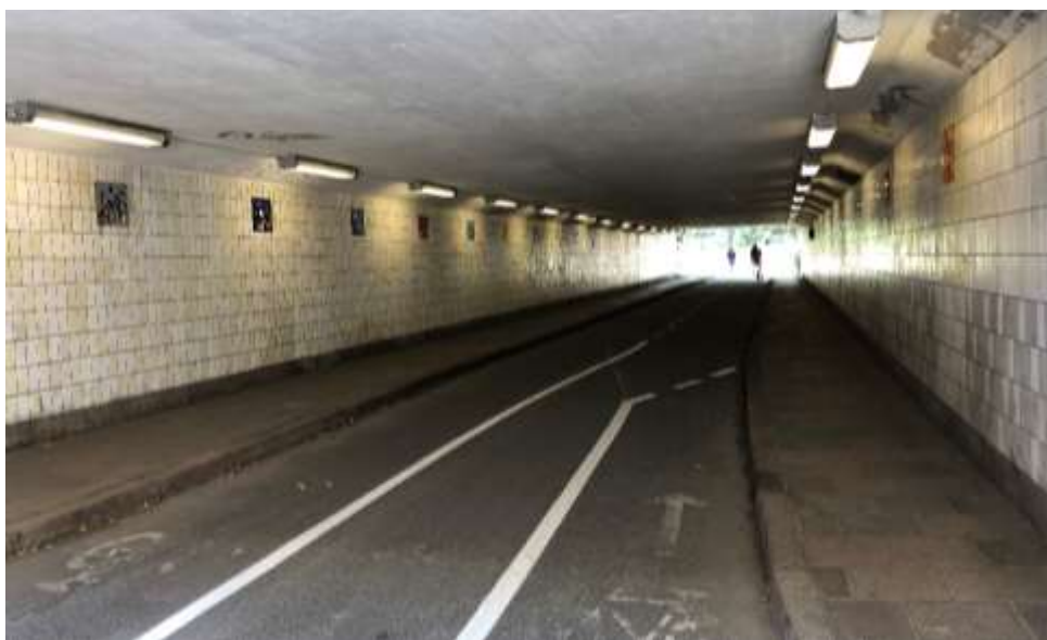
Figur 4 Gångbanor och cykelbana i västra sidan av tunneln.
