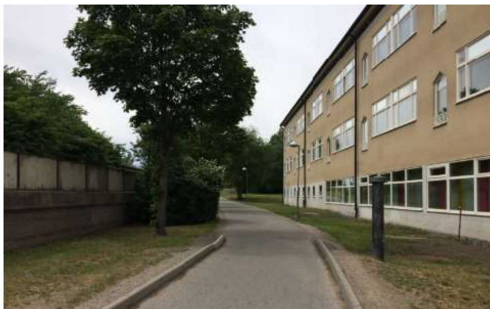
Figur 10 Gång- och cykelvägen på sträckan förbi Värmdö gymnasium.
