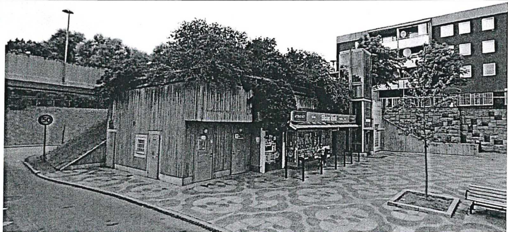
Tenstaplan, murar på terrasser och vid trappan upp från "torget" upp mot sim- och idrottshallen.
