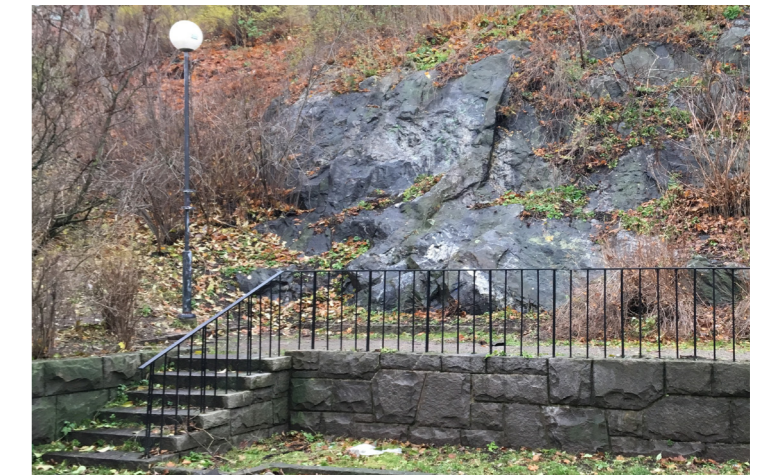
Till höger: Nya räcken, handledare, trappor och murar utformas lika befintliga. Bild: Tyréns.
