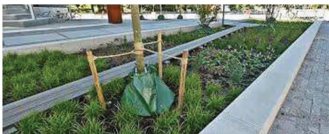
Öppen dagvattenlösning med växtbädd - Norra Djurgårdsstaden. En plantering som även förmår ta om hand, fördröja och rena dagvatten är både exempel på mångfunktionalitet och en så kallad LOD-åtgärd (lokalt omhändertagande). Foto: Lennart Johansson
