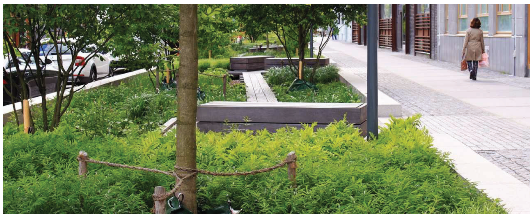
Exempel på förstärkt dagvattenhantering i ett exploateringsprojekt: Regnbäddar på Jaktgatan i Norra Djurgårdsstaden. Foto: Lennart Johansson
