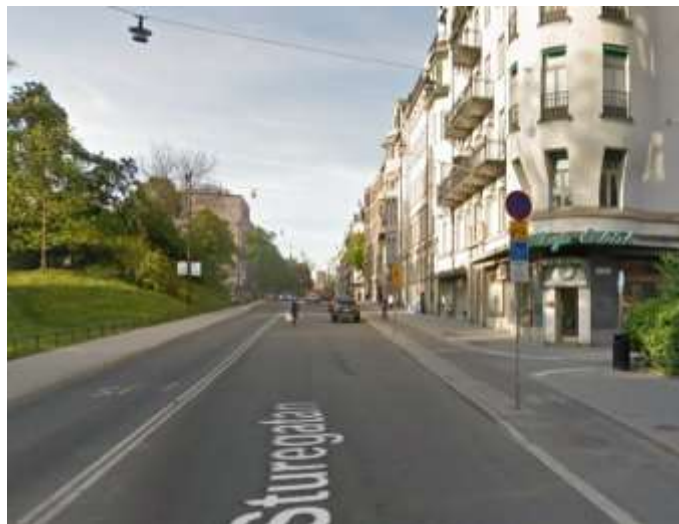
Bild 8 Sturegatan före åtgärder.
