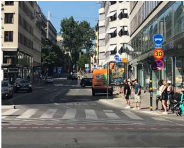
Bild 5 Refugen vid korsning Hamngatan/Norrlandsgatan efter utförda åtgärder
