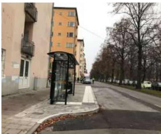
Bild 13 Valhallavägen efter utförda åtgärder
