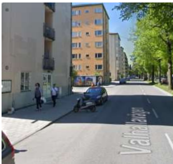
Bild 12 Valhallavägen före åtgärder
