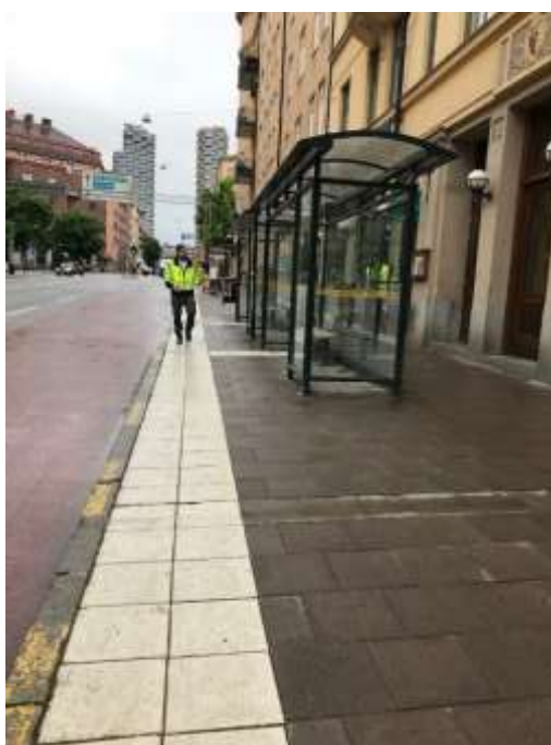
Bild 14 Torsgatan vid Karlbergsvägen före åtgärder
