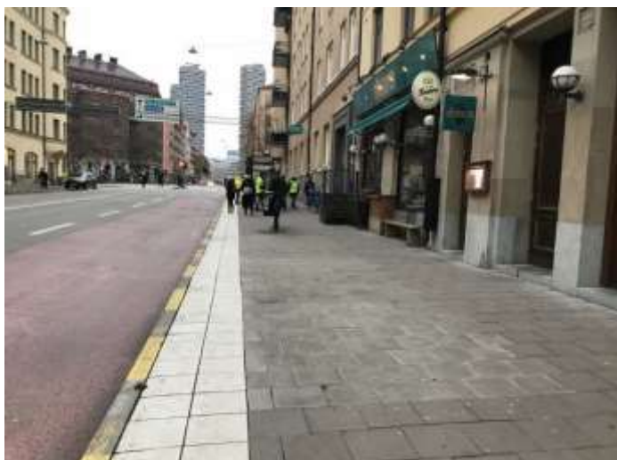
Bild 15 Torsgatan vid Karlbergsvägen efter utförda åtgärder
