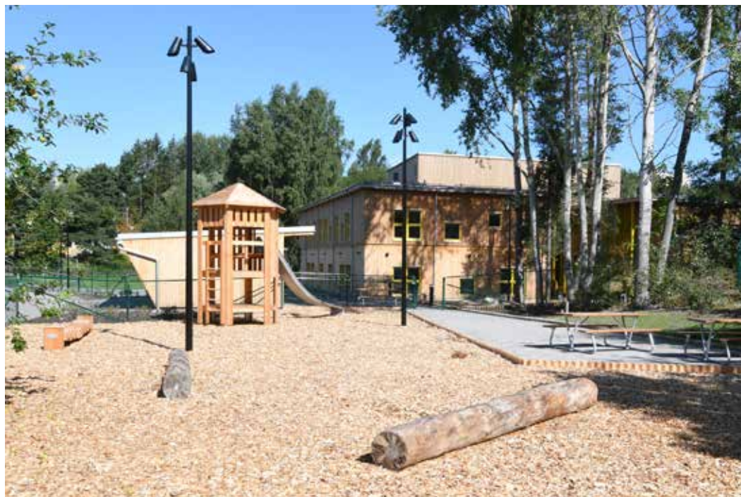
Den nya förskolan Vattenhjulet stod klar sommaren 2021 och är kommunens första konceptförskola. Förskolan är byggd med en stomme av KL-trä med en stor del av ytskikten i trä. Fasaden består av en träpanel som med tiden kommer att gråna. Arkitekter: Tengbom
