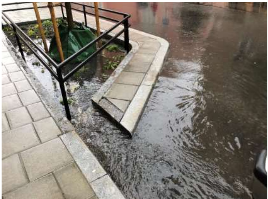
Figur 3: Nytt träd på Rehmsgatan med synlig dagvattenhantering.
