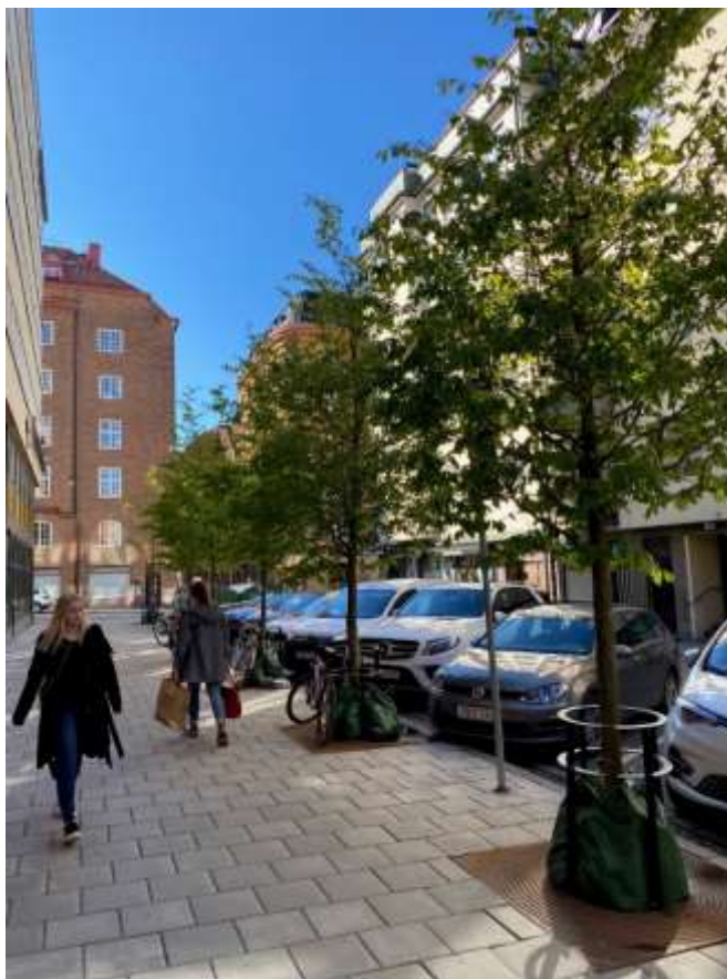
Figur 5: Luntmakargatans gångbana efter ombyggnation 2018. Gångbanan har breddats och den släta ytan underlättar passage.
