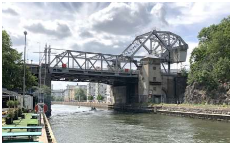
Bild 3. Befintlig bro, sedd norrifrån.
