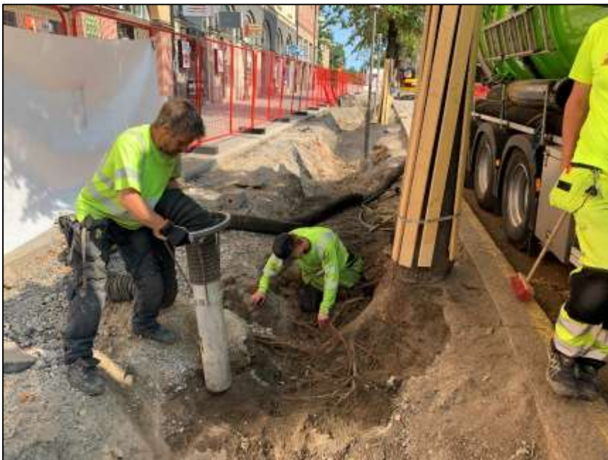
Figur 24. Vakuumschakt vid trädens rötter, pågående projekt på Sankt Eriksgatan. Trädet har ett tillräcklig bra rotsystem för att kunna behållas.
