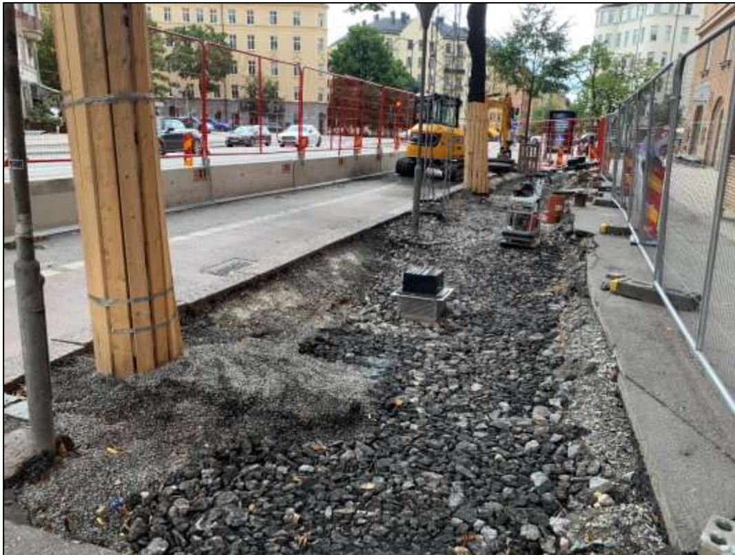
Figur 25. Den nya växtbädden för träden, med biokol och makadam i grövre fraktioner.
