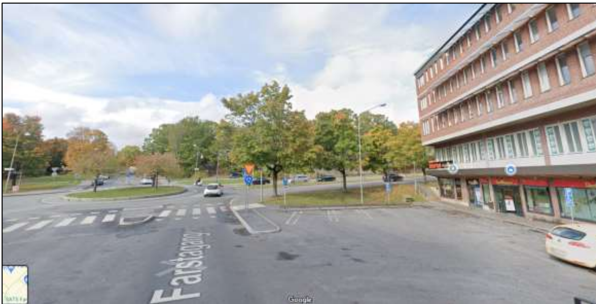
Figur 2. Bild från lägsta punkten. Senast sommaren 2021 översvämmades butikerna till höger i bild, vatten stod en bit upp på skyltfönstren
