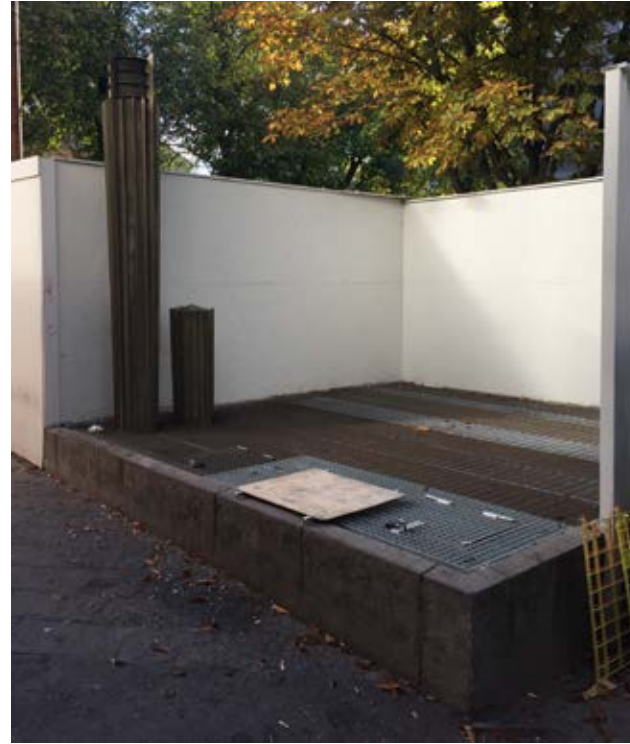
Befintligt frånluftsgaller byts mot ny perforerad plåt. Foto Nivå
