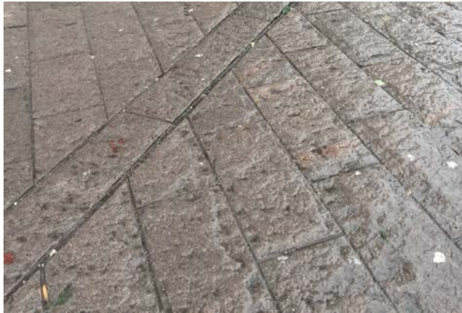
Rester av den gamla stenen på platsen. Foto Nivå
