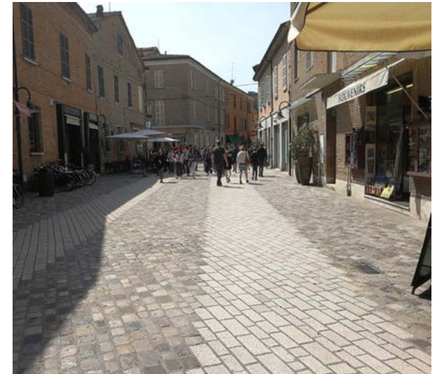
Referensbilder flätning av gammal sten med ojämn yta och nutida tillägg av slät, tillgänglig sten . Foto Nivå
