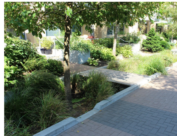
Dagvattendammar fördröjer och renar dagvattnet på gårdarna. Planteringarna tillgängliggörs via spångar.
