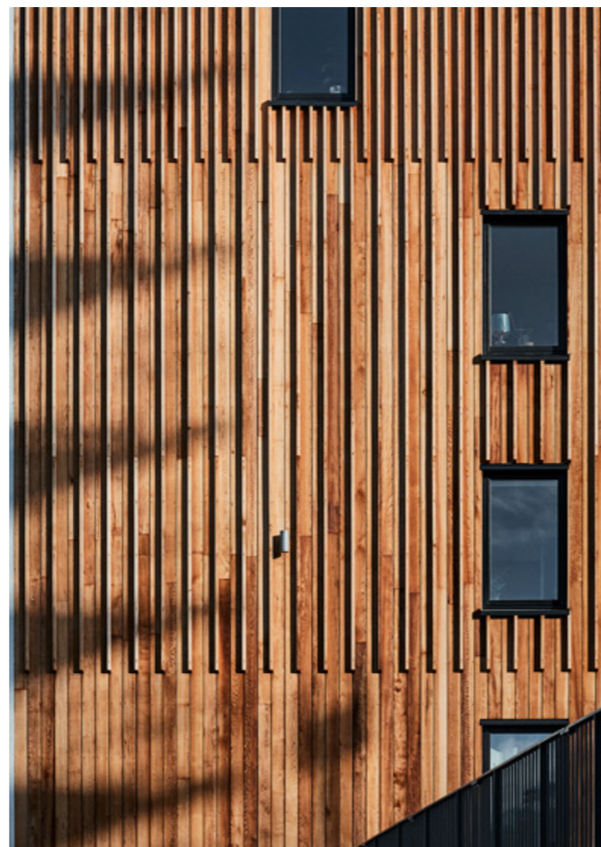
Kraftig läkt markerar fasaden Dinell Johansson/ Sjöhusen
