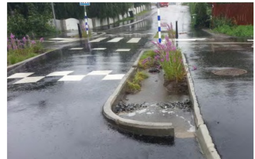
Exempel på välfungerade raingarden för lokalt omhändertagande av dagvatten i vägmiljö, Öringevägen i Tyresö.
