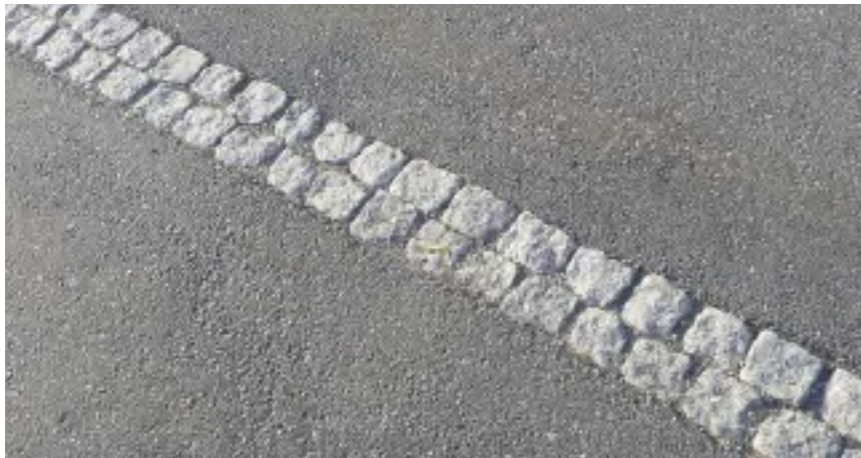
Fris av smågatsten som markering i asfaltsyta.
