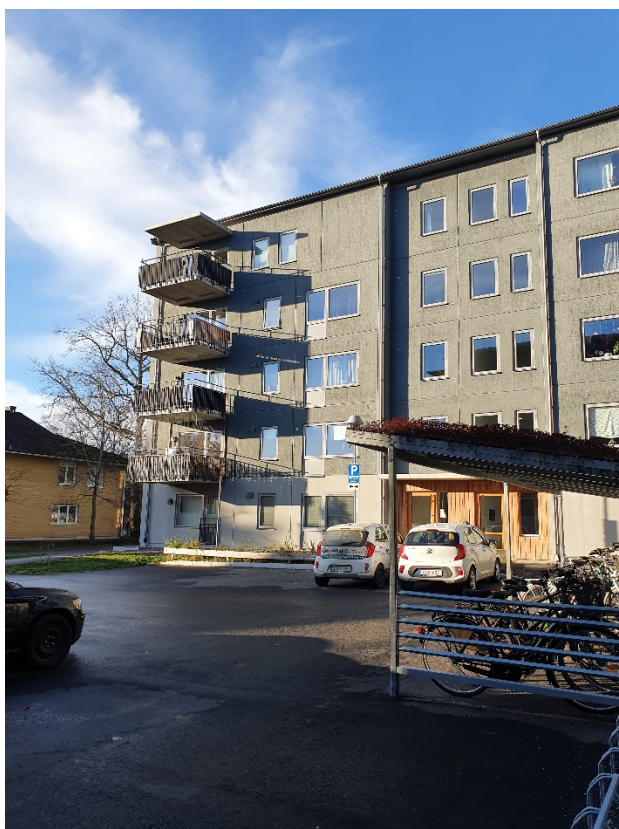
Entréfasad med hårdgjorda ytor framför för angöring och markparkering.
