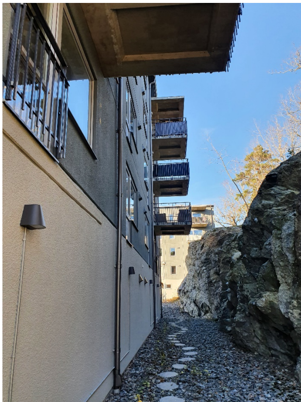
Stegplattor mellan byggnad och bergskärning
