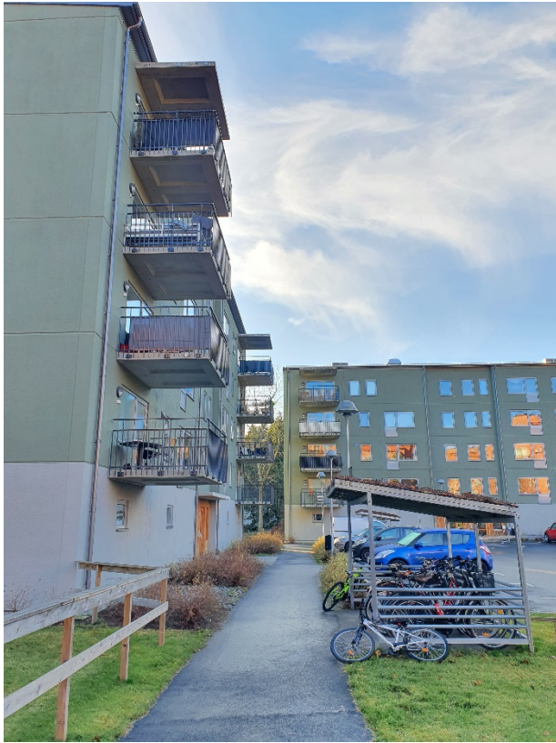
Entréväg och cykelparkering med grönt tak
