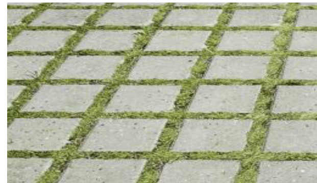
Gräsarmeringssten med insatt gräs på P-platser på gästparkeringen.
