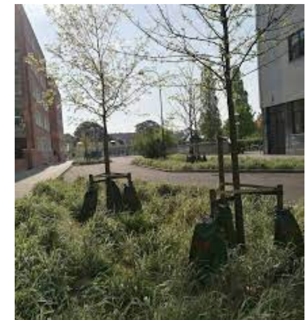
Nedsänkt växtbädd i grönytor närmast byggnaden
