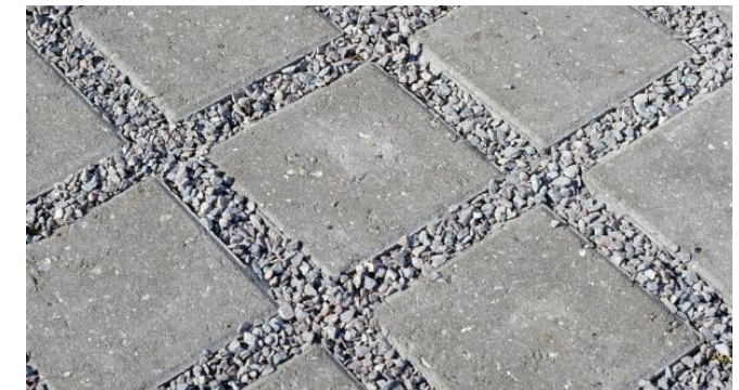
Grusarmering på körytor på gästparkeringen
