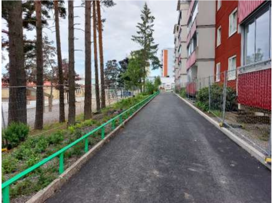
Bild 3. Efter ombyggnad. (belysningsstolparna inte uppsatta än)
