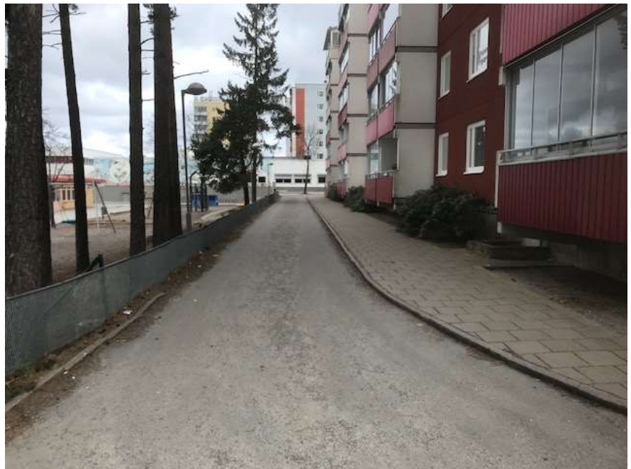
Bild 2. Gångväg längs Husbygårdsskolans skolgård mot centrum. Före ombyggnad.
