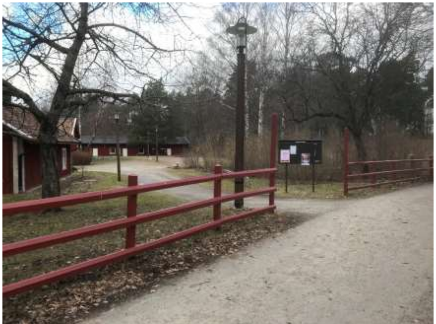
Bild 4. Entré till Husby gård. Före ombyggnad.
