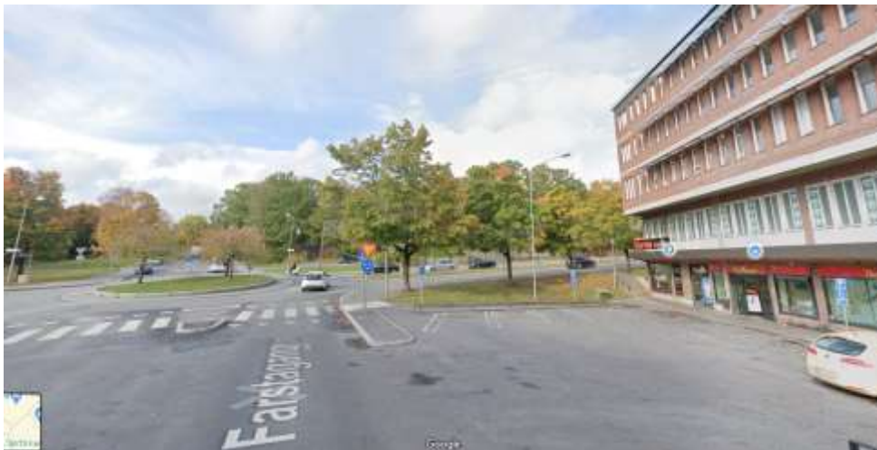
Bild från lågpunkten. Senast sommaren 2021 översvämmades butikerna till höger i bild, vatten stod en bit upp på skyltfönstren
