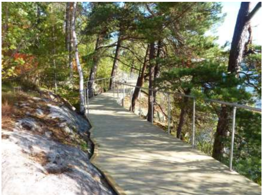
Bild på gångbanedäck från tidigare etapp av strandpromenaden.
