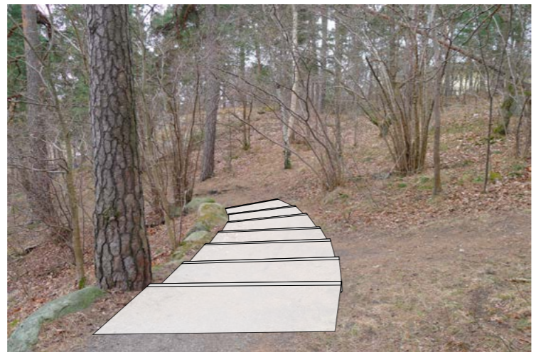
A. Åsne stig anläggs i backe med mycket rötter och nytt rör läggs under stigen för att avleda vatten
