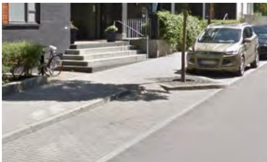
Parkeringsfickor markeras mot körbana med kansten i nivå med asfalten.
