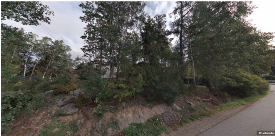
Figur 4. Fastigheten Stenen 7 sett från Tjärnstigen.
