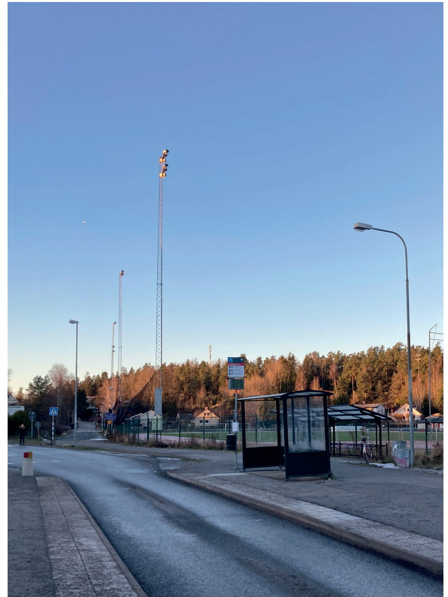
Timglashållplats för ökad trafiksäkerhet på lokalgator.
