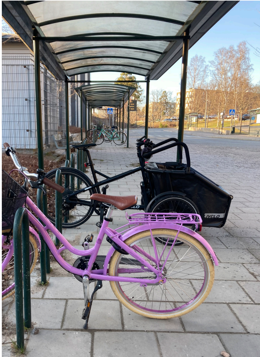
Väl utformad cykelparkering vid busshållplats.
