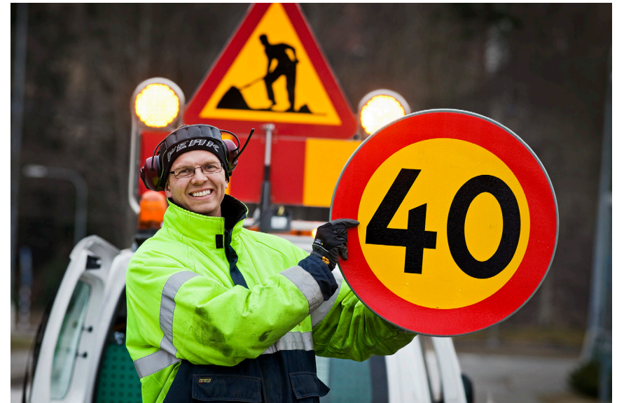
Tydlig skyltning bidrar till bättre framkomlighet under byggtid.
