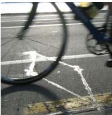
Cyklar räknas automatiskt av slingor som ligger nedfrästa i asfalten.
