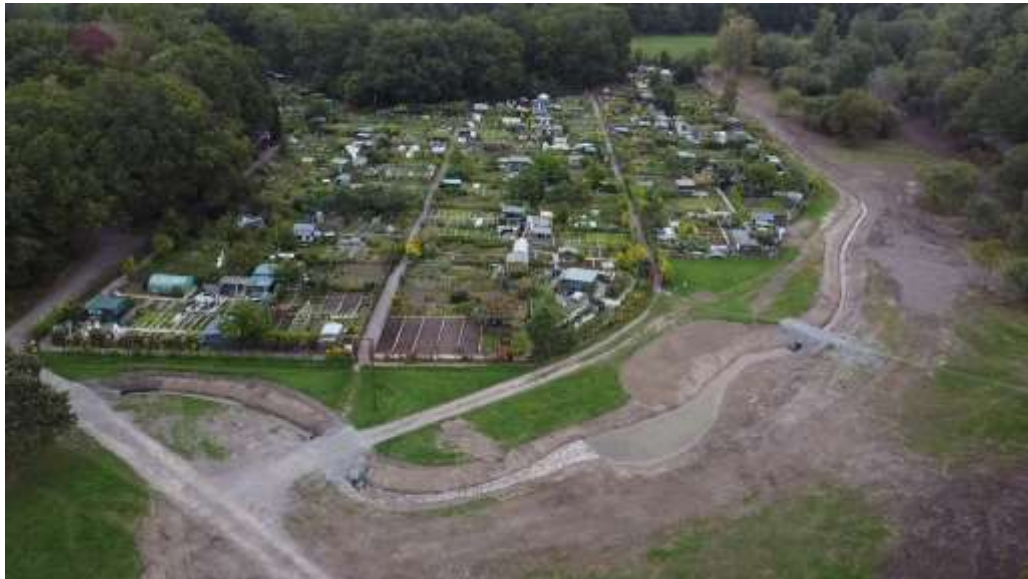
I augusti 2021 fick Skärholmsbäcken en ny bäckfåra. Tidigare gick den i kulvert under koloniområdet
