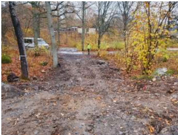
Inspektion av Svenska kraftnäts arbetsområden i Rågsved inför återställande.
