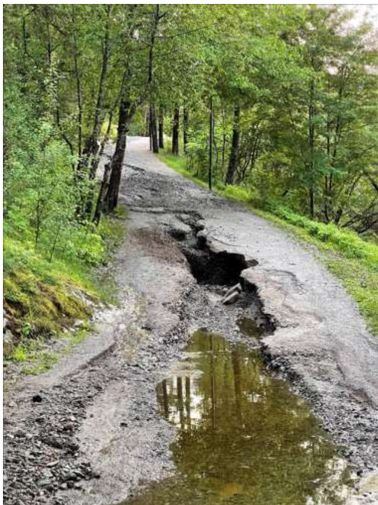
Sommarens skyfall skapade stora problem på gångvägarna längs Årstaviken.
