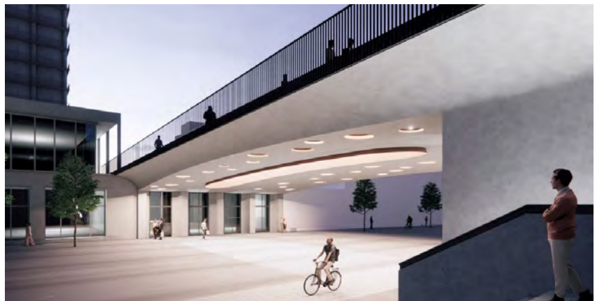
Förslag 2: En avlång öppning i bron som kan släppa ned dagsljus föreslås (Bild: Wingårdhs)
