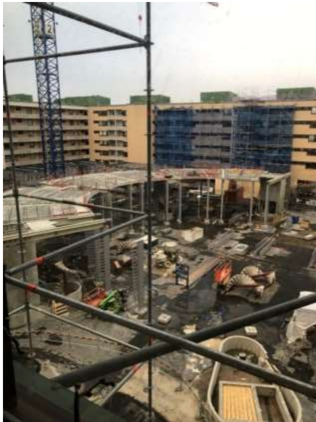
Figur 16. Vy över kvarteret Plankans bakgård strax innan arbetena avbröts. Foto: miljöförvaltningen, Stefan Troäng
