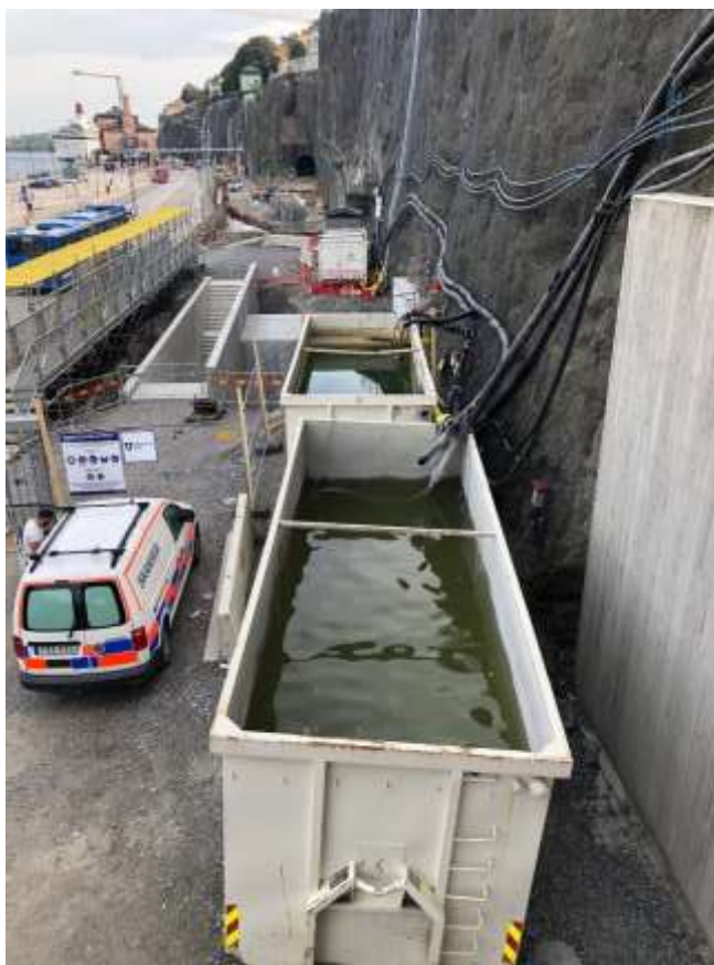
Figur 3 Rening av länshållningsvatten från byggandet av nya bussterminalen i Katarinaberget. I bakgrunden ses också Citylinks arbetsområde för luftschakt. foto Miljöförvaltningen, Stefan Troëng
