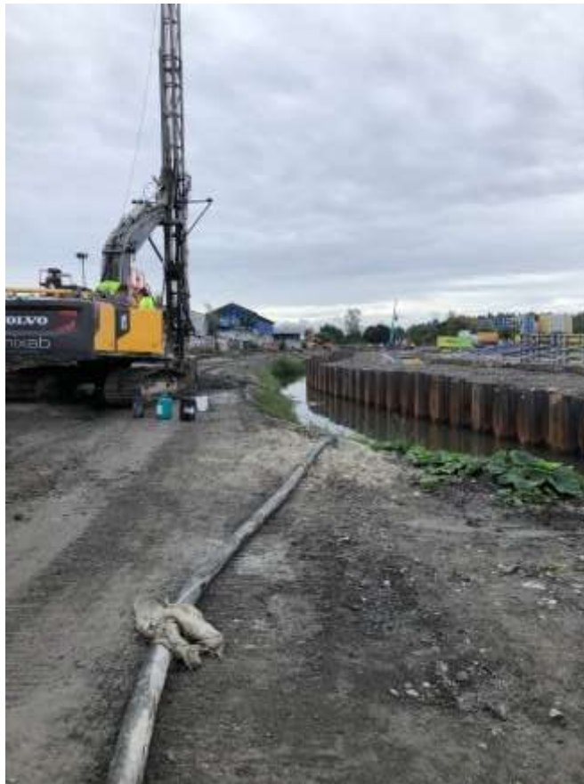
Figur 15 Markarbeten inför byggandet av Bromstensstaden. Foto: Miljöförvaltningen, Stefan Troëng
