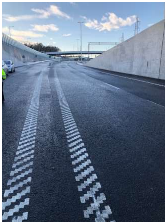
Figur 1 Norrgående nedfartsramp till tunnlar vid Kungens kurva Foto Miljöförvaltningen, Stefan Troäng
