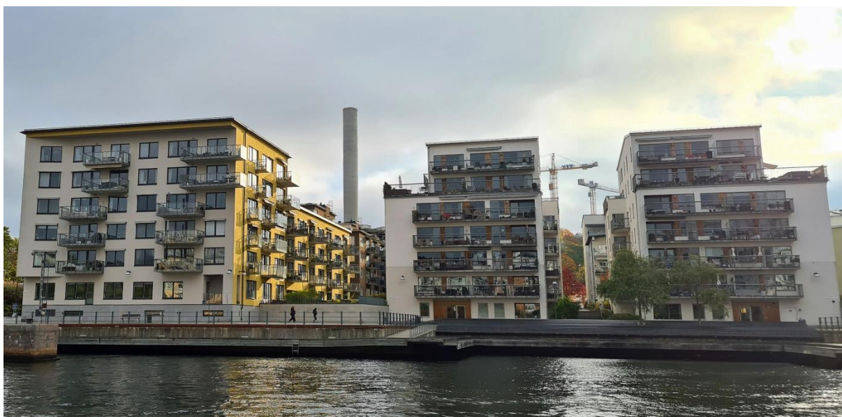
Henriksdals reningsverks skorsten sticker upp bakom husen i Hammarby sjöstad. Foto: Joakim Lücke.
