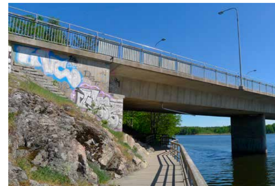
Foto från vy 3, befintliga gångbana under bron.
