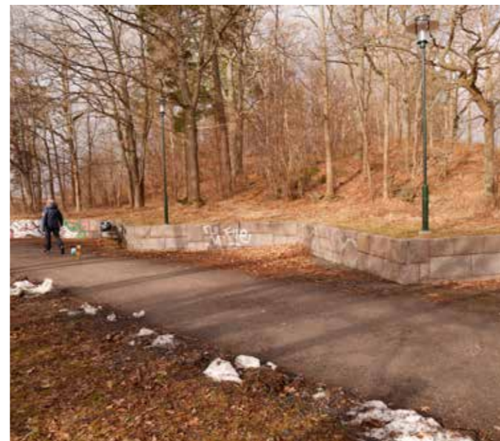
Foto från vy 1, befintlig mur.
