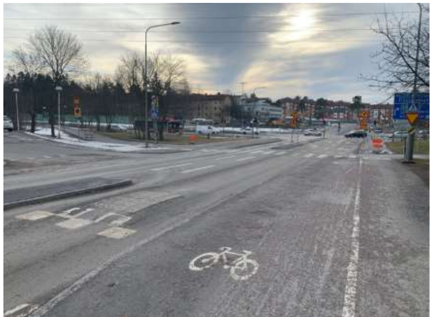
Figur 10: Grycksbovägen, efter ombyggnaden, nu med en utbyggd refug och farthinder.
