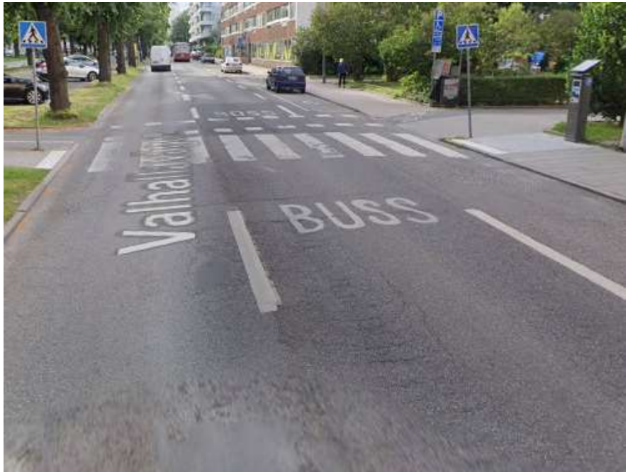
Figur 1: Valhallavägen i riktning från Gärdet, före ombyggnaden och utan farthinder.
