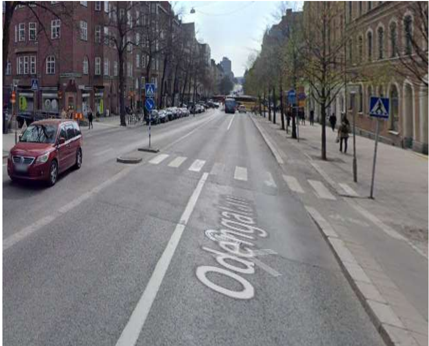
Figur 3: Odengatan/Bragegatan, före ombyggnaden, utan farthinder och förlängd refug.
