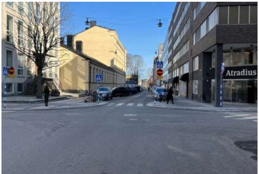
Figur 6: Rådmanngatan/Teknologgatan, efter ombyggnaden, nu med två stycken öron (en lokal breddning av gångbaneytan som ger en lokal avsmalning av gatan) som ger en kortare väg för fotgängare.
