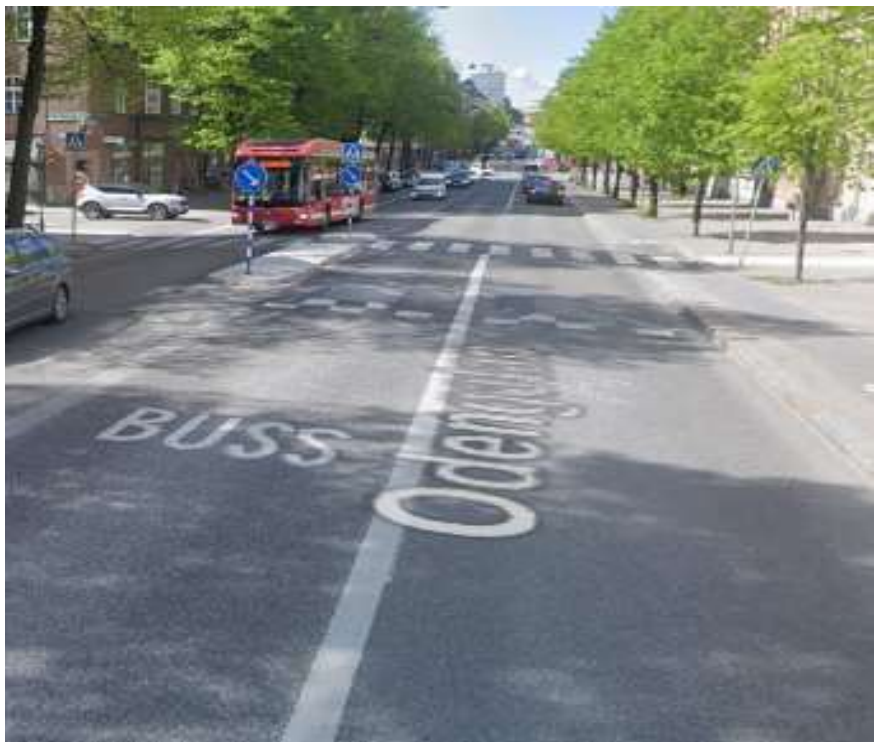
Figur 4: Odengatan/Bragegatan, efter ombyggnaden, nu med farthinder och förlängd refug.
