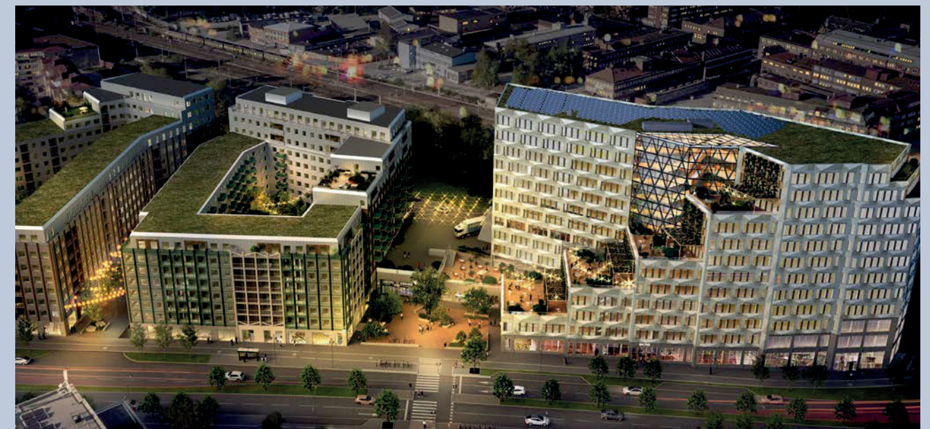
Komplext läge invid Solnavägen, Järnväg och ovanpå ny T-station.
