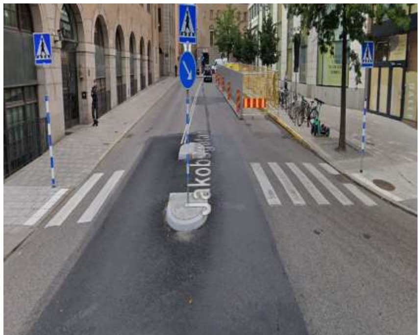
Figur 2: Övergångsställe på Jakobsgatan efter ombyggnaden. Kompletterande målningsarbete ska utföras under våren 2022.
