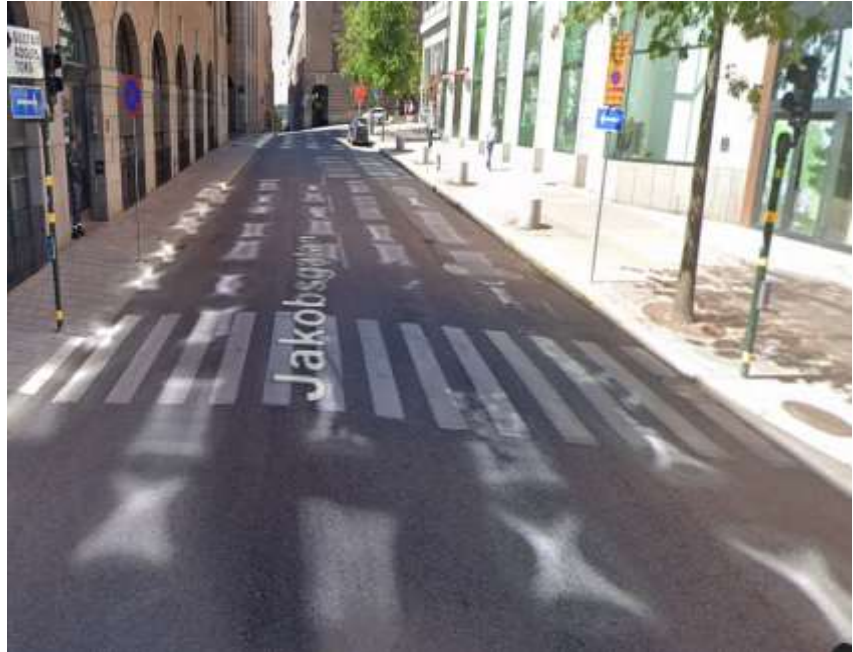
Figur 1: Övergångsställe på Jakobsgatan innan ombyggnaden.
