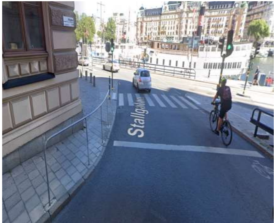
Figur 5: Stallgatan 9 innan ombyggnaden.
